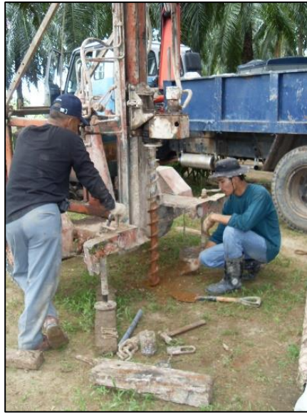
Plet 2. Proses penggerudian dalam yang menerusi kaedah putaran pacuan hidraulik menggunakan flight-mounted solid auger di aplikasi di Sungai Batu Sumber: Nor Khairunnisa 2009
