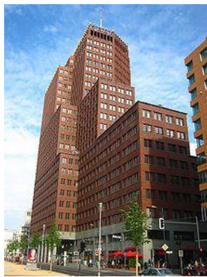
Gambarajah 8 Bangunan Hans Kollhoff, Berlin menggunakan bahan binaan sumber asli iaitu menggunakan batu bata dari tanah liat
