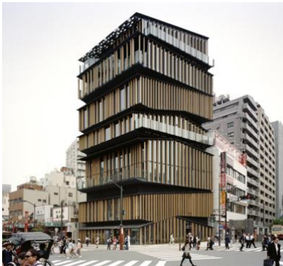
Gambarajah 6 Bangunan Pusat Maklumat Pelancongan Budaya Asakusa menggunakan kayu sebagai fasad bangunan.
