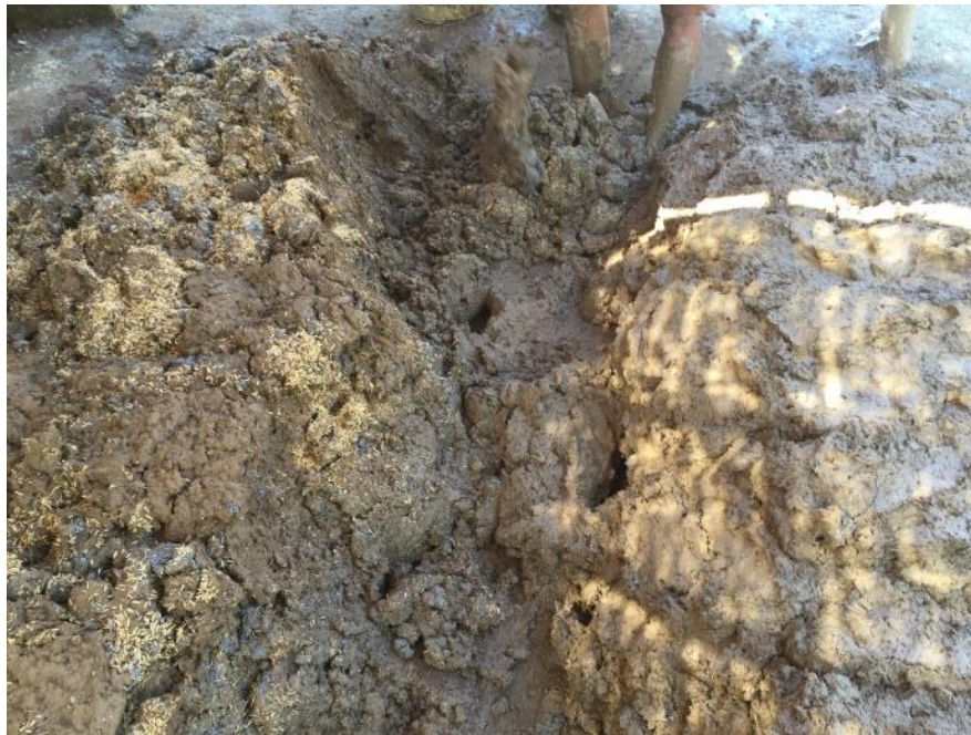
Gambar 4. Bancuhan tanah liat, air dan sekam padi secara manual
