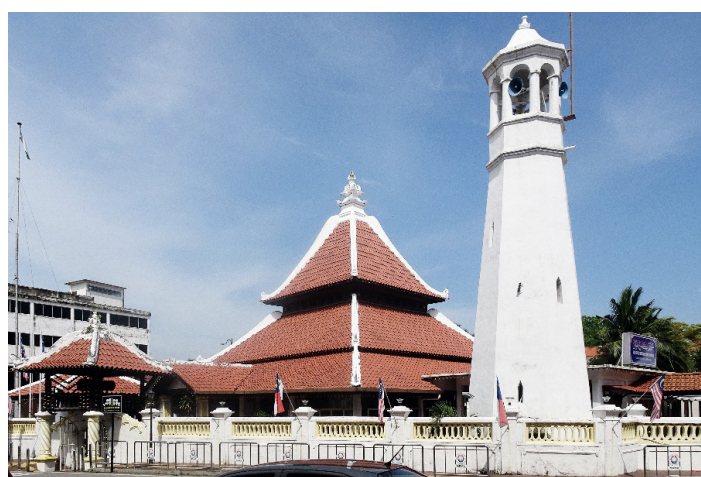
FIGURE 3. Masjid Kampung Hulu, Melaka
