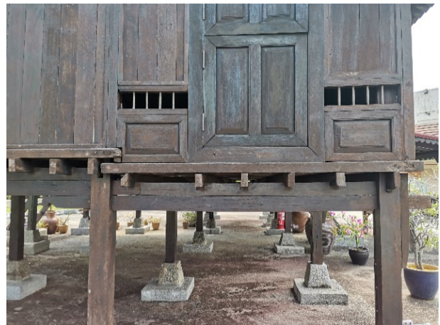
RAJAH 18. Aras lantai serambi gantung yang lebih rendah (kanan) dari lantai ruang utama (kiri) di bahagian rumah ibu (Rumah Serambi Negeri Sembilan, Rembau) menunjukkan hierarki dan pembahagian antara ruang Sumber: Penulis (2022)
