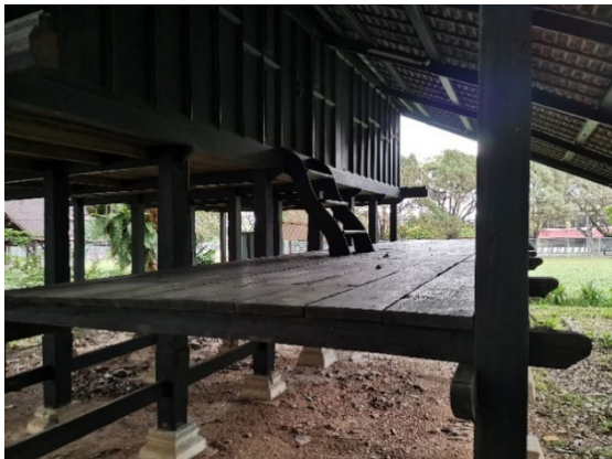
RAJAH 12. Pelantar serambi terbuka 'selasar' di hadapan Rumah Bujang Berselasar, Kuala Terengganu Sumber: Penulis (2020)
