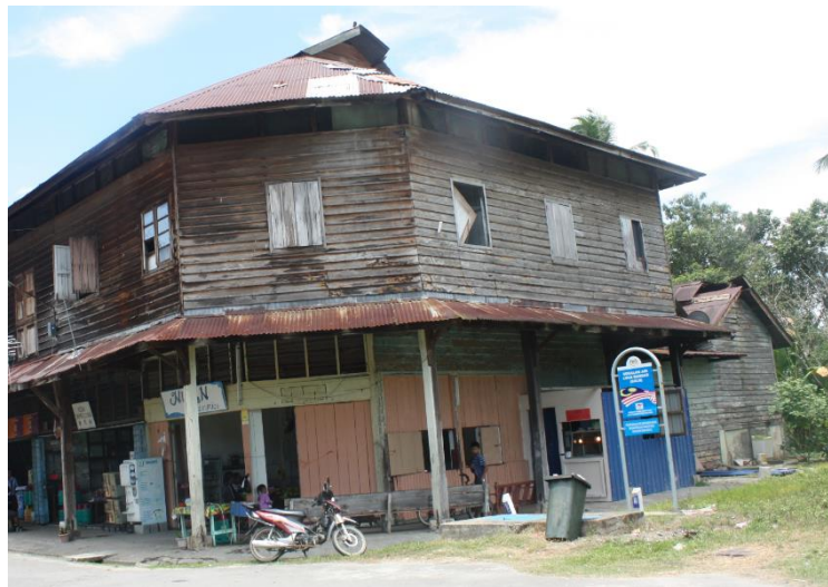
Foto 17. Lot no. 6 merupakan bahagian bangunan yang telah mengalami pengubahsuaian yang jelas. Dinding luar tingkat bawah digantikan dengan papan baru tetapi lebih tipis berukuran 1 cm dan dicat dengan warna hijau terang. Namun bahagian pintu masih menggunakan daun kepingan papan yang berlipat dicat dengan warna jingga. Daun jendela tingkat atas menggunakan daun kaca seperti pada Lot no. 1 tetapi lima buah jendela lain telah digantikan dengan daun papan menegak. Bahagian atap jelas memperlihatkan penggantian zink dilakukan. Lot ini merupakan satu-satu kedai makan di bangunan ini yang berfungsi sehingga bangunan ini runtuh Sumber: Kajian lapangan 25/3/2014
