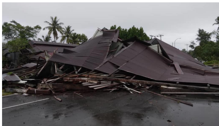
Foto 13. Struktur bangunan bahagian utama bertingkat yang musnah sepenuhnya menjelang subuh pada 12/10/2022
