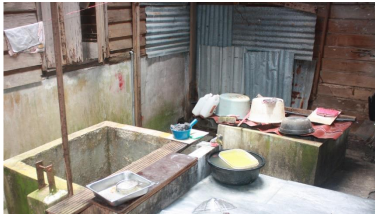
Foto 19. Dinding papan yang telah digantikan dengan kepingan zink di ruang dapur
