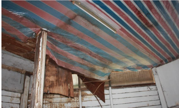
Foto 10. Manakala atap yang berlubang hanya ditutupi kain plastik pada bahagian dalam Sumber: Kajian lapangan 25/3/2014
