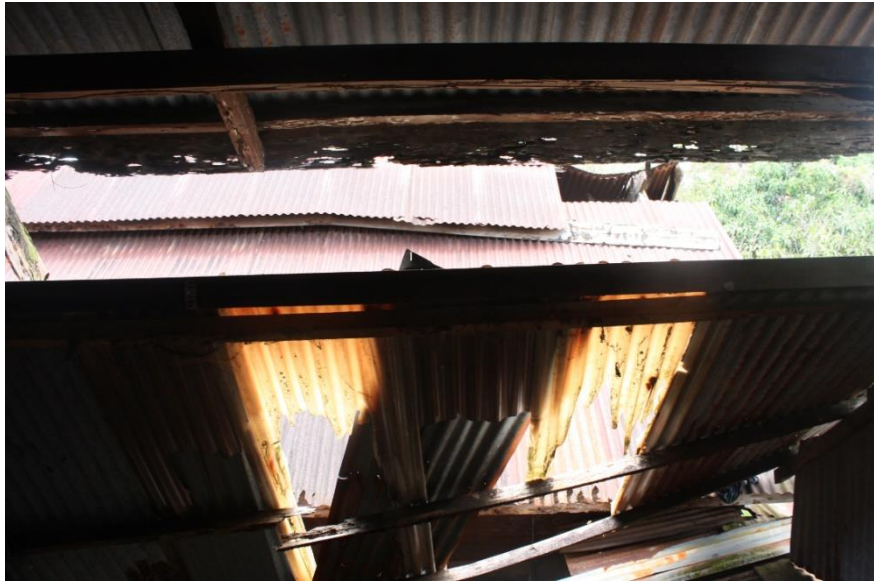
Foto 8. Pengubahsuaian atap keping zink yang berbeza ketebalan dan berat menyebabkan beban atap meningkat
