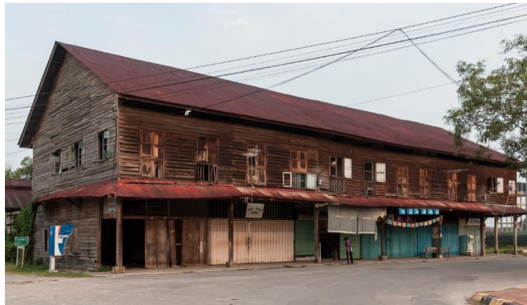
Foto 11. Struktur luar bangunan pada tahun 2012 masih menunjukkan bahagian atap dan tingkat atas yang terpelihara
