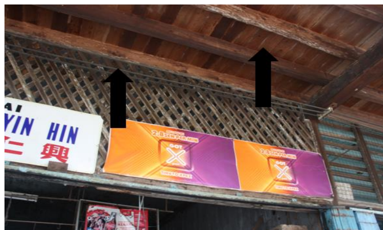
Foto 5. Tetulang bagi siling atau lantai tingkat atas berukuran 10 x 20 cm yang sudah dimakan anai-anai. Sumber: Kajian lapangan 25/3/2014
