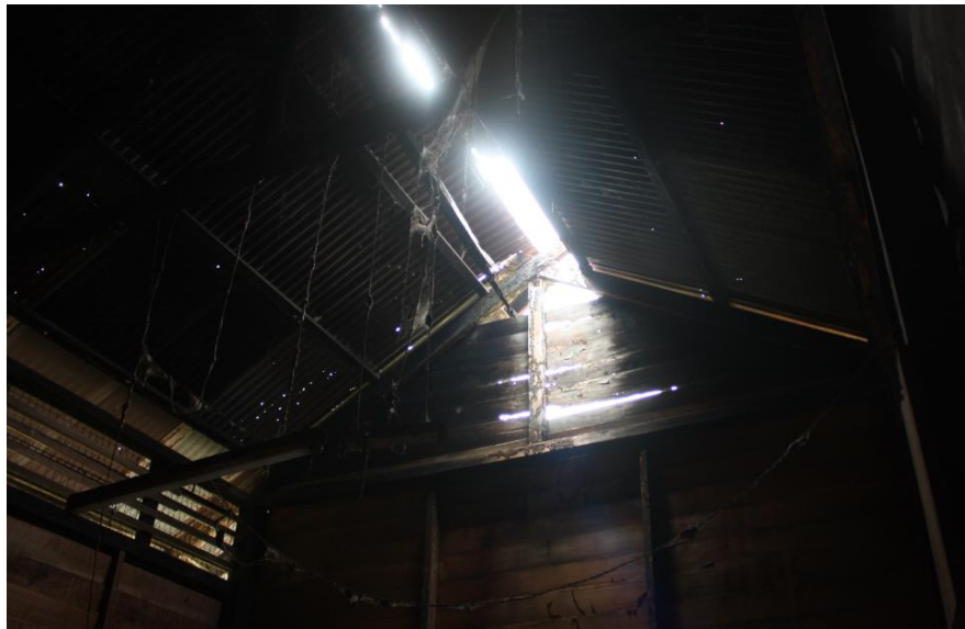
Foto 9. Begitu juga penambahan atap untuk melindungi bahagian tengah dari air hujan turut menyumbang kepada beban atap bertambah
