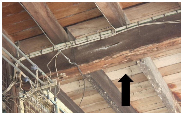
Foto 4. Di antara tujuh batang tiang utama terdapat tujuh batang palang berukuran 30 x 30 cm untuk menyokong lantai tingkat atas bangunan Sumber: Kajian lapangan 25/3/2014
