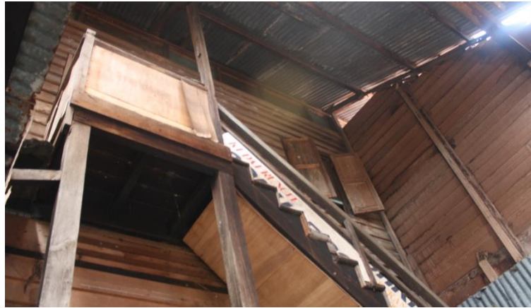
Foto 18. Struktur ruang dapur juga tidak mempunyai tiang yang kukuh hanya batang kayu berukuran 10cm x 15cm dengan atap tanpa alang bumbung penyambung tetapi faktor ketinggian dan ruang yang tidak luas lebih kurang menanggung beban atap yang lebih kecil saiznya
