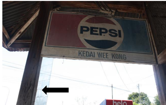
Foto 3. Tujuh batang tiang utama berukuran 30 x 30 cm untuk menyokong bahagian depan bangunan Sumber: Kajian lapangan 25/3/2014
