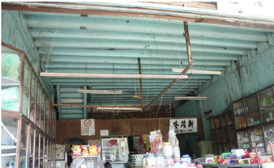
Foto 6. Tetulang bagi siling ruang bawah atau lantai tingkat atas bahagian dalam kedai yang dicat berukuran 10 x 20 cm yang sudah dimakan anai-anai Sumber: Kajian lapangan 25/3/2014
