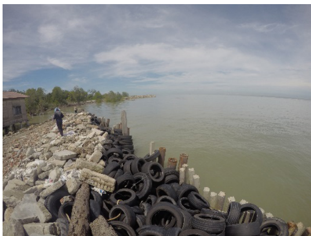
RAJAH 2. Struktur keras buatan manusia sebagai pertahanan pantai.
